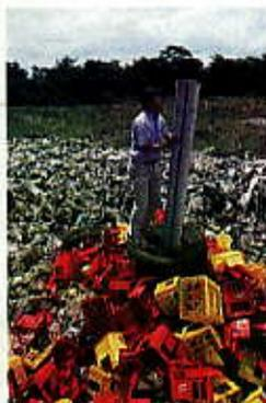
ガス抜き管と発生ガスを点検する天野さん（右）。「先端から浸出水が吹き出て、スプーンで元のろ過装置に拡散します」とごみから出た汚水を処理する原理を説明（下）
