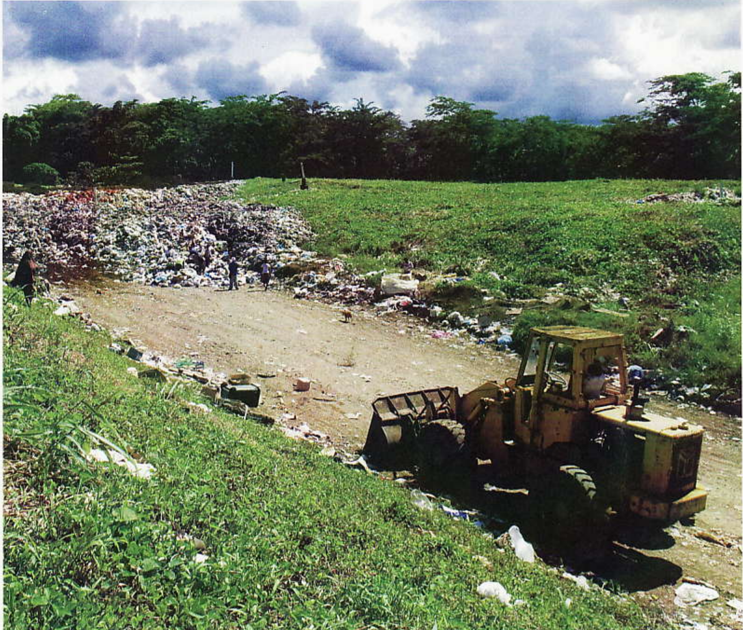
「福岡方式」を取り入れ、改善されたサモアのタファイガタ処分場。ごみ収集車が到着すると、まずウェストピッカーがごみの中から有価物を探す。その後、重機でごみを一か所に集め、踏み固める
